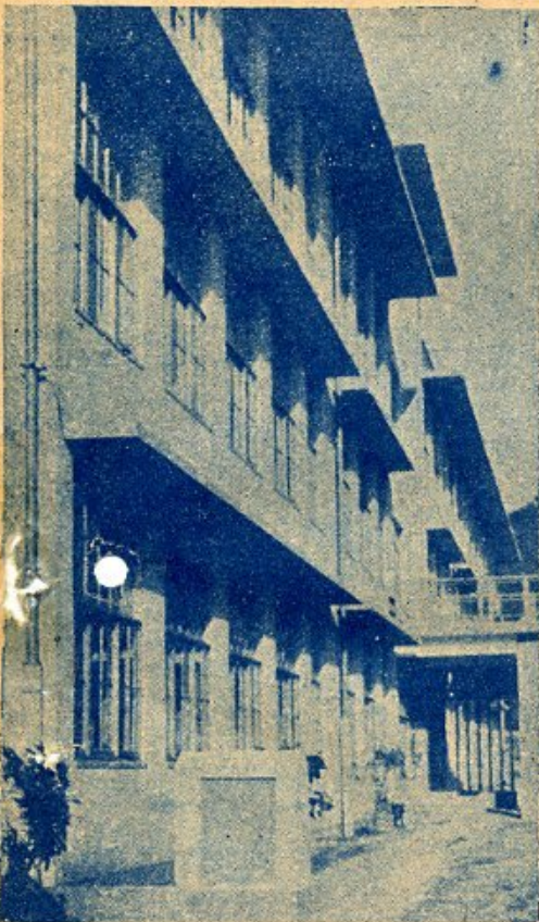
西中学校体育館：本校舎裏側に28年8月竣工、二二九坪の鉄骨鉄筋コンクリート造平家建の近代建築として29年3月竣工。総工費三七、六七二千円で株式会社松村組が施工したもの。山陰随一。
