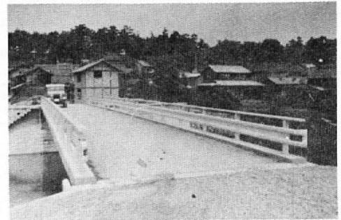
(完成した賀露橋)
