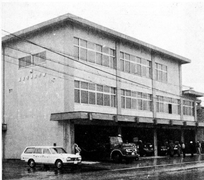
完成した消防庁舎
