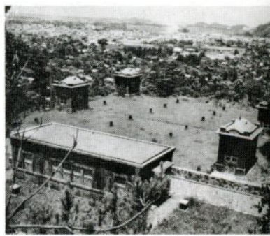
改築が行われる上町配水池
