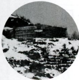
築造中の下味野配水池
