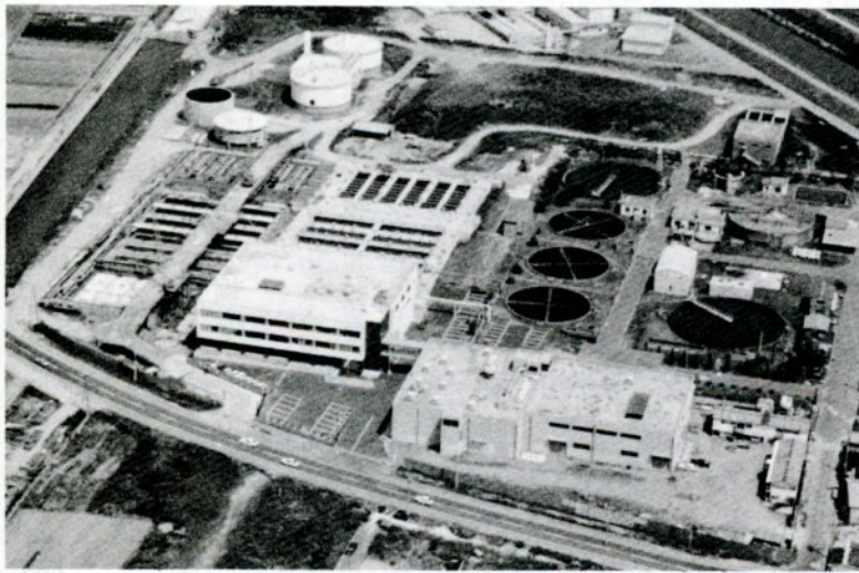
▲空から見た下水終末処理場。現在、四万一千人分の汚水処理を行っている。
