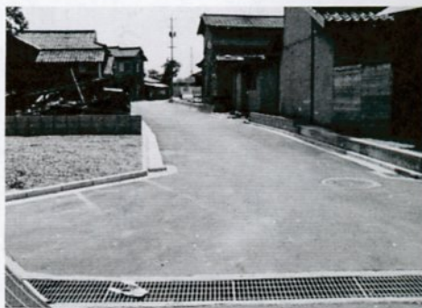
舗装され広がった道路—古海地内で
