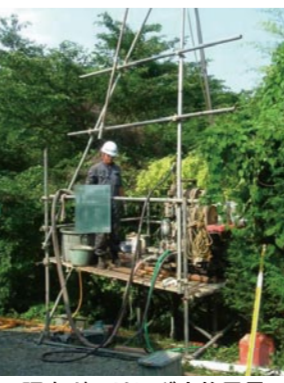
調査ボーリング実施風景
