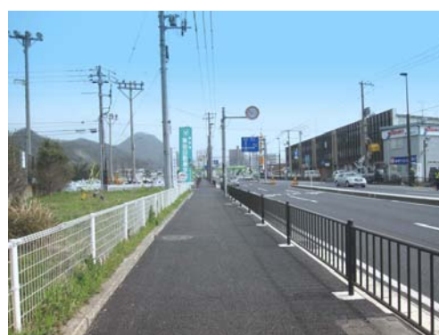
秋里地内（下水道処理場前）
