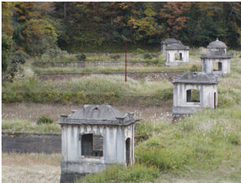
旧美歎水源地水道施設(平成 19 年 6 月 18 日 国指定文化財)
