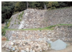
修理が進む天球丸跡
