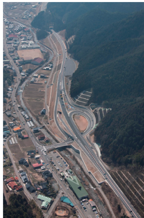
西粟倉 IC 周辺 (国交省鳥取河川国道事務所提供)
