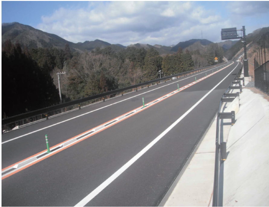
新開通区間 大原 IC～西粟倉 IC間 後山橋周辺 (国交省鳥取河川国道事務所提供)
