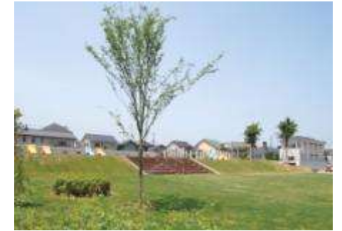
西町緑地整備 【平成23年度完了】
