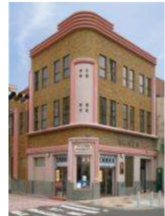
五臓圓ビル再生活用 【平成22年度完了】
