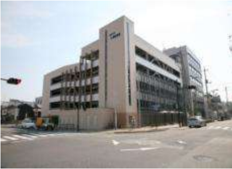
市営片原駐車場改築 【平成22年度完了】
