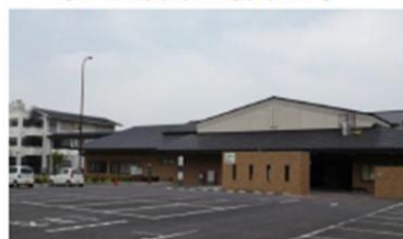
市立図書館の新築工事
