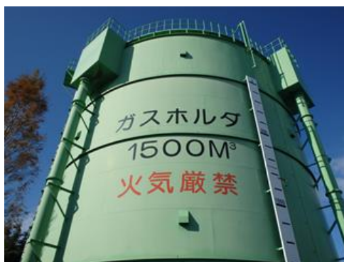
消化ガスタンク
