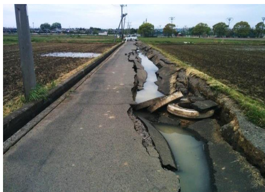
汚水幹線の路面陥没(出所：国土技術政策総合研究所資料)
