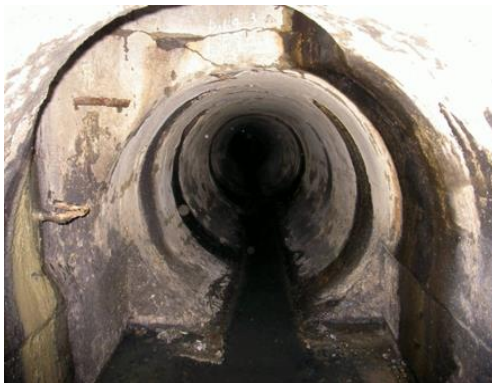
老朽下水管の状況
