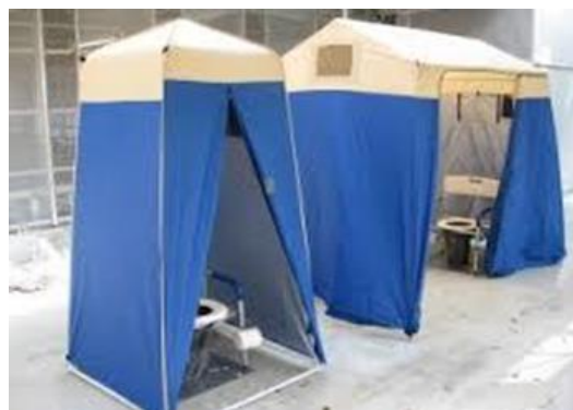
マンホールトイレ
