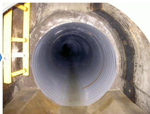
管更生実施後
