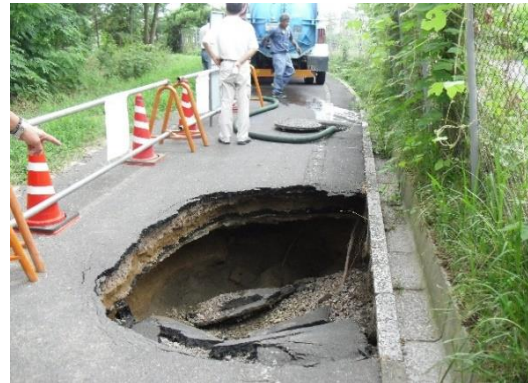
鉄筋コンクリート管の腐食による道路陥没
