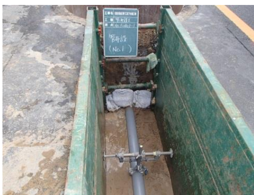
汚水管の敷設
