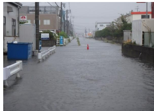
大雨時の冠水状況
