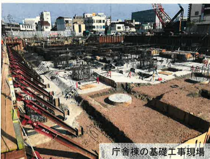
南西側上空から見た現在の工事現場
