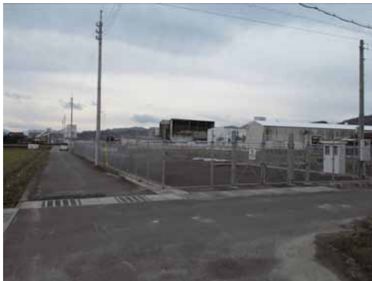
（注）上味野の土地の現在の状況（フェンスの内側が水道用地）
