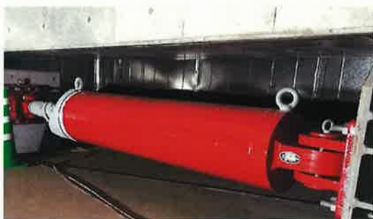
（地震エネルギーを吸収する装置）
