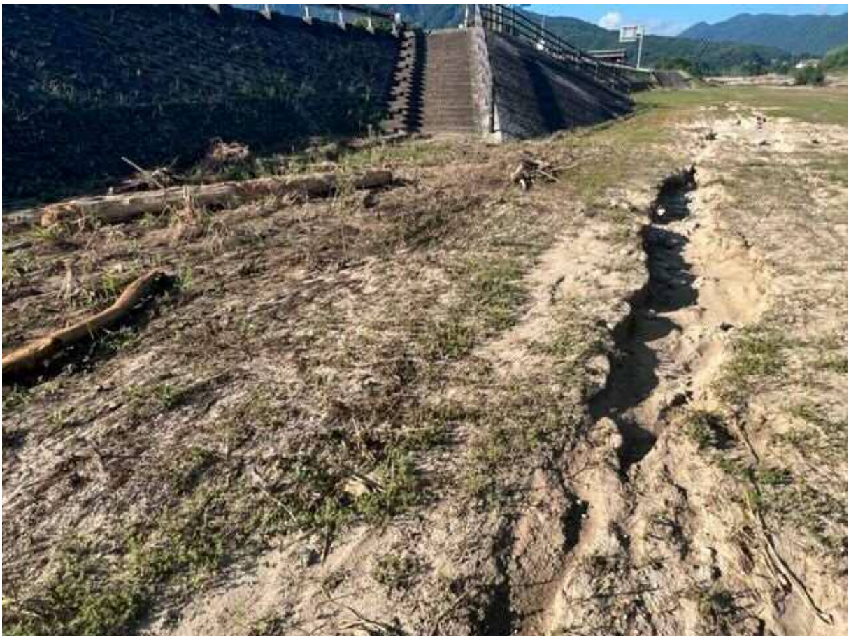
河内川増水による河川公園越水（土砂等流入および地面の洗掘）
