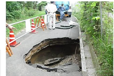
鉄筋コンクリート管の腐食による陥没事故
