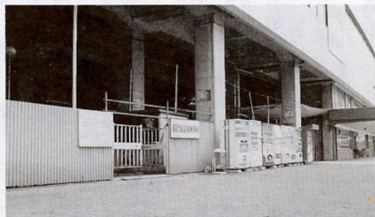
鳥取駅高架下の仮設自転車駐車場
