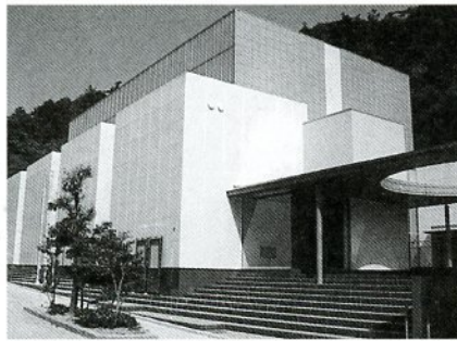
完成した博物館の外観
