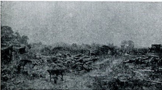
高草中学校校舎整地作業
