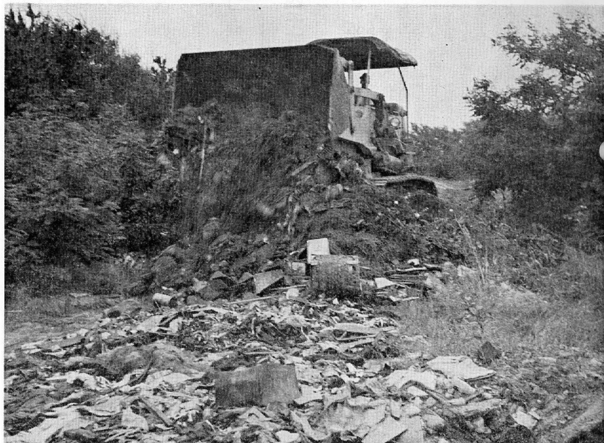
捨てられたゴミの山をかたずけるブルドーザー (砂丘にて)
