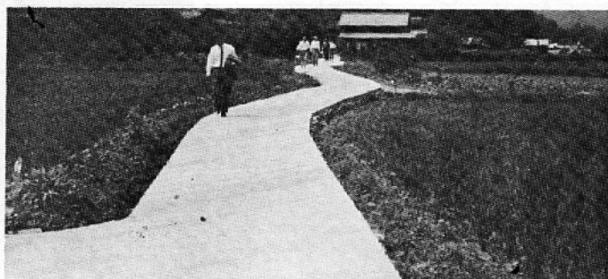
完成した生山部落内舗装
