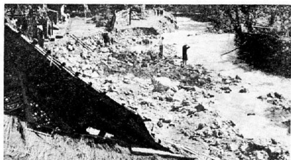
おし流された民家と堤防
