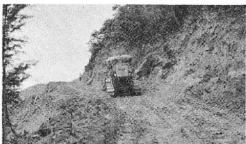
完成間近い十神林道
