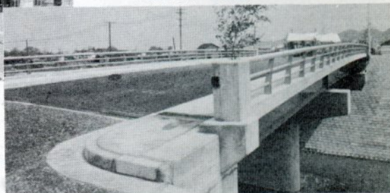
↓完成した「大宮橋」
