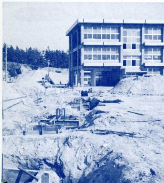
資材高騰で補正予算を組み工事を進める（浜坂小学校で）
