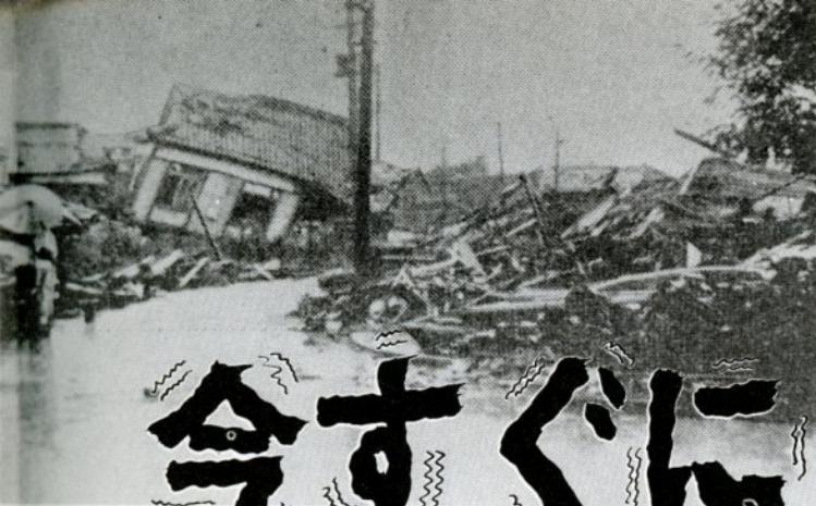
大きな二階建ての家もまるでワラ灰のようにくずれた鳥取大地震の惨状
