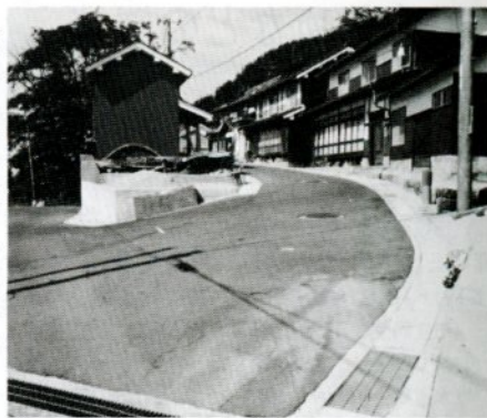
幅5.1mの幹線道路2路線が新設された円通寺地区
