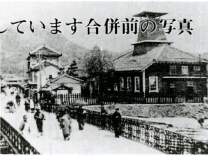
明治後期の智頭橋
