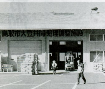
62年11月服部地内に完成した 大豆共同処理調整施設
