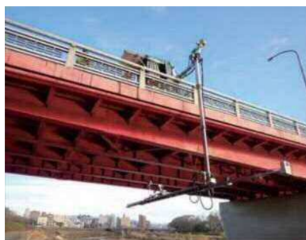
橋梁点検支援ロボットによる点検
