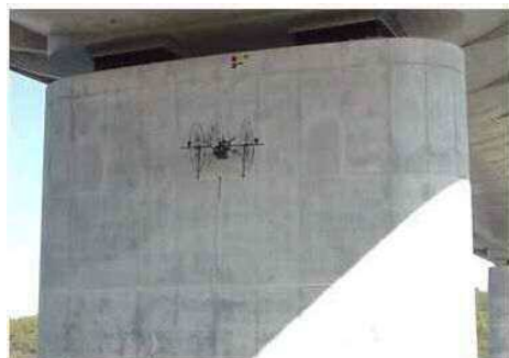
ドローンによる点検
