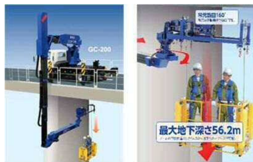
ゴンドラ点検車による点検
