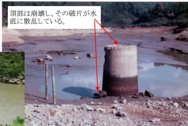
外壁(水抜き後)
