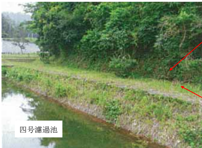
四号濾過池沿い 石造擁壁
