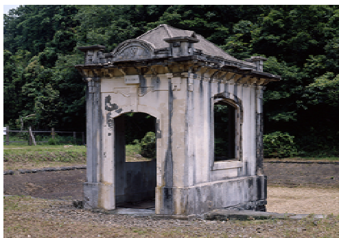
外観正面(南側より)
