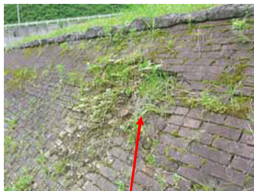
擁壁：一部損傷や孕み
