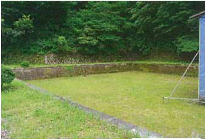
五号濾過池外観
