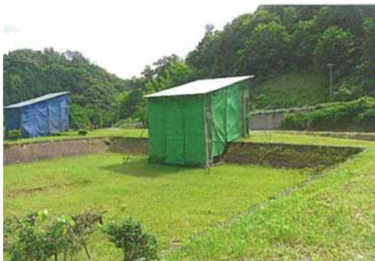
一号濾過池外観
