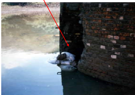
外壁(水抜き後)
