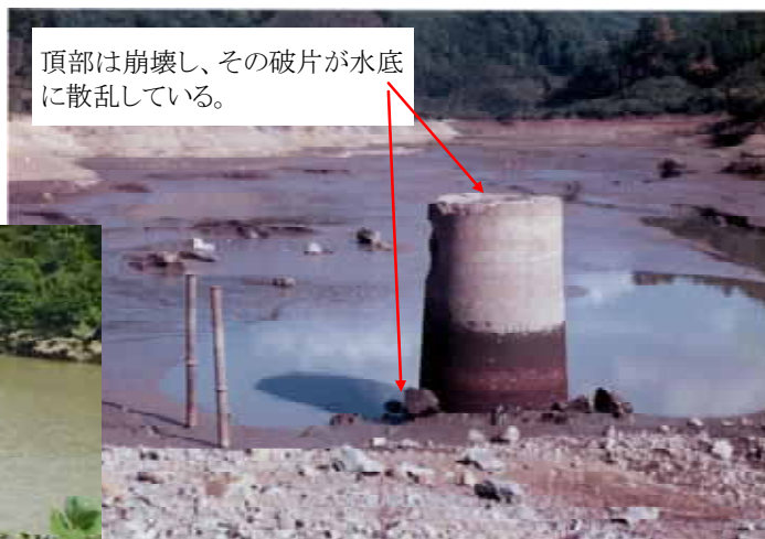
外壁(水抜き後)
