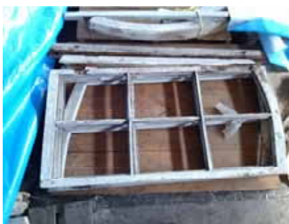
一号濾過池窓
