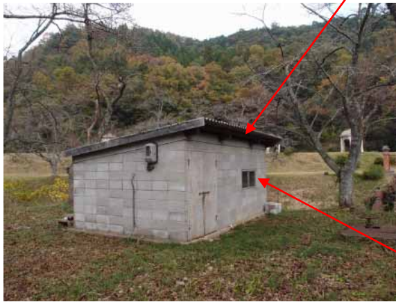
窓枠、窓材の更新
