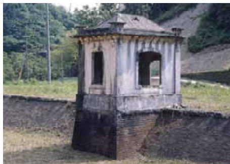
外観測面(北側より)
