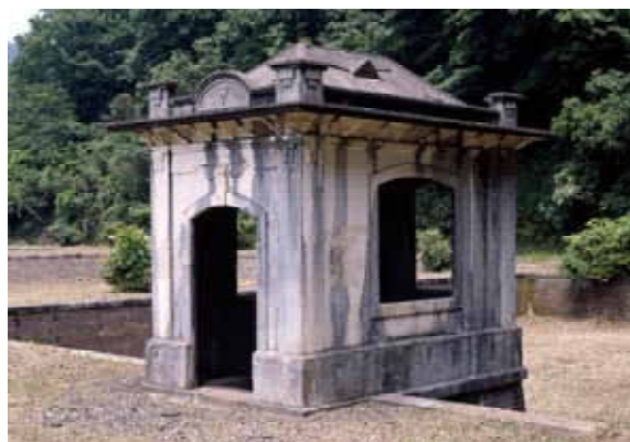
外観正面(南側より)
