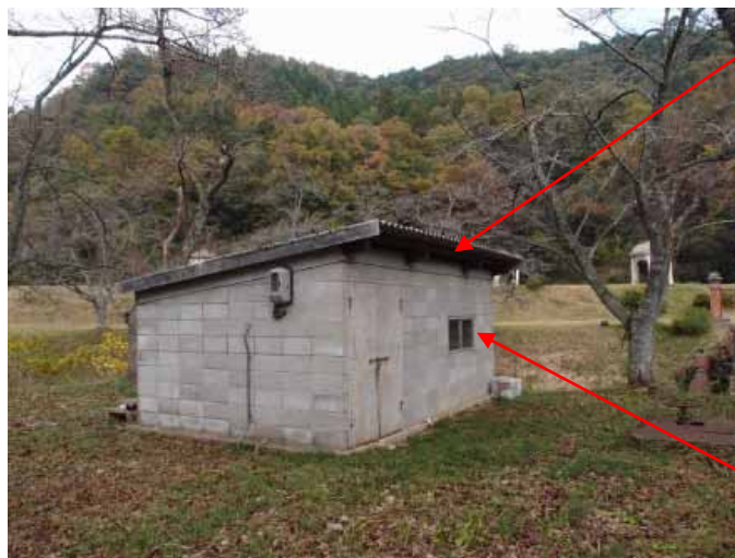
屋根材の更新
