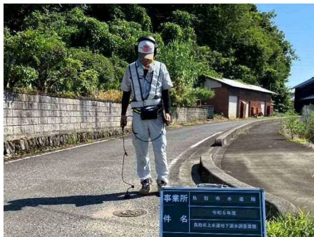
漏水調査状況 (音聴調査)
