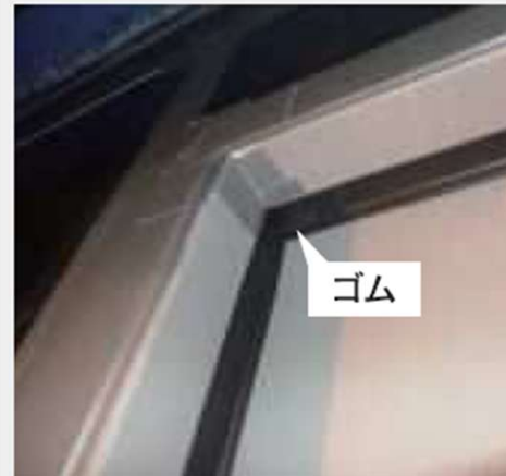
①上枠及び召合わせに設置した気密ゴム
