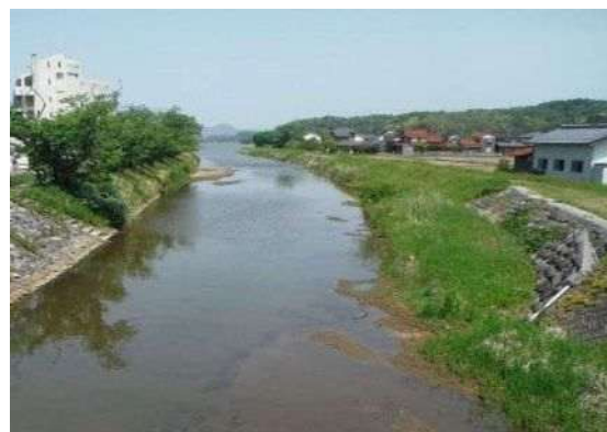
環境に配慮した河川整備の例 (湖山川)
