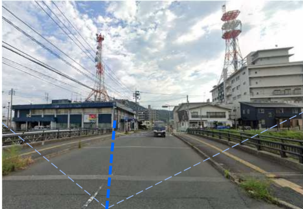
① 弥生橋通り（弥生橋南橋詰）
