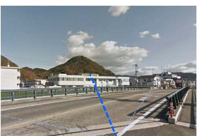
⑥ 国道53号線（湯所橋西橋詰）
