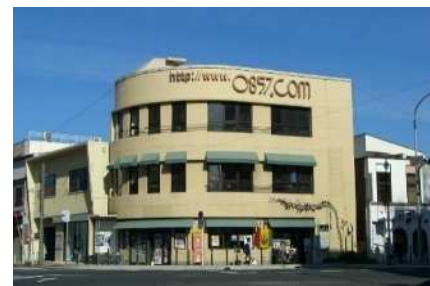
敷地形態（角地）に配慮した丸みのあるデザインによって、圧迫感を和らげています。
