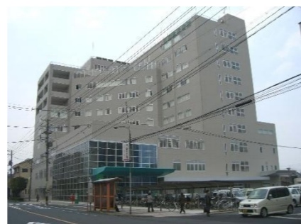
建物外観の色彩を落ち着いた色調にすることによって、周辺景観との調和を図っています。
