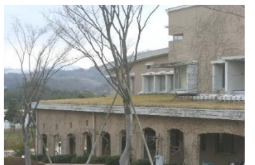
屋上緑化は、景観向上の他にも、ヒートアイランド現象の緩和、省エネルギーなど、様々な効果をもたらします。
