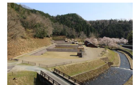
【旧美敷水源地水道施設】
