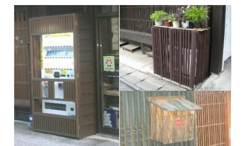
エアコンの室外機、自動販売機などを木製格子等の自然素材で包み込めば、街なみが良好な景観に生まれ変わります。
