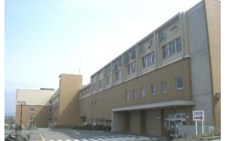
低層部分と上部を同系色（2色）のタイルで仕上げ、壁面にリズム感を与えています。
