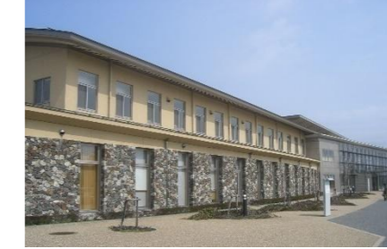
石とタイルの異なる素材を用い、建物に味わいのある表情をつけています。
