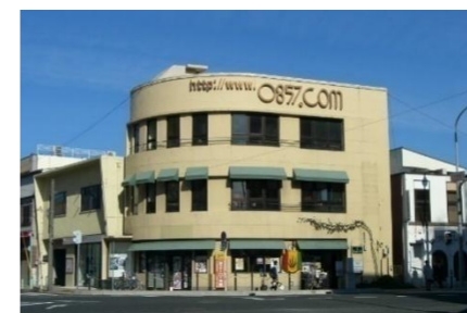
敷地形態（角地）に配慮した丸みのあるデザインによって、圧迫感を和らげています。
