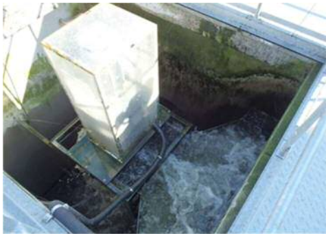
図 3-7 小水力発電機
