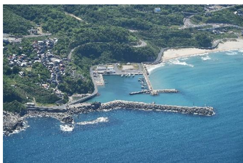
漁港施設の改修（夏泊）
