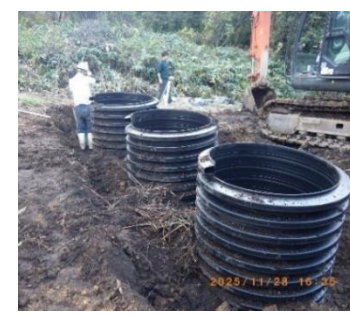
大型排水管を活用した減容化施設（施工中）
