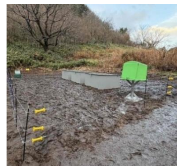
大型排水管を活用した減容化施設（施工後）
