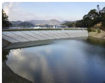
ため池の改修
