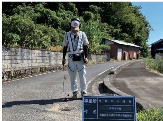
漏水調査状況 (音聴調査)
