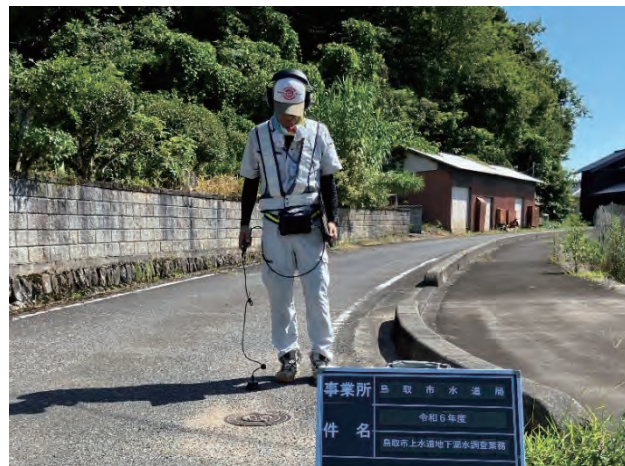
漏水調査状況(音聴調査)
