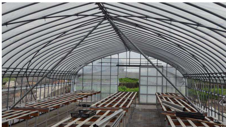
写真11 斜め支柱設置の例
