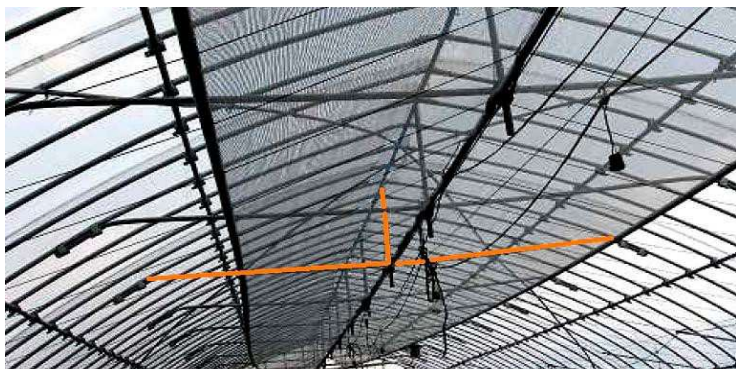
写真1 タイバー設置の例
