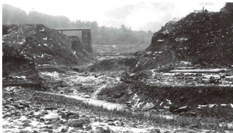
写真75 大正7年の台風により決壊した堰堤（鳥取市教育委員会所蔵）
