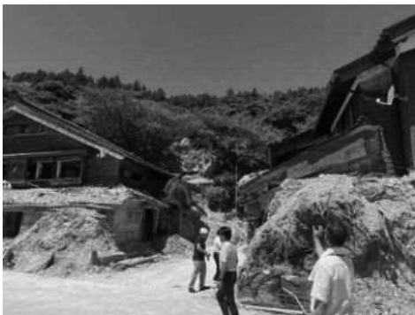
【写真1】土砂の流入により1階部分が埋まる家屋
