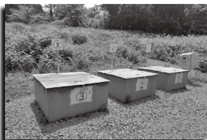
完成した3基の排水管
