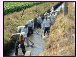
水路の泥上げ
