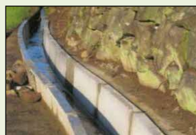
素堀り水路からの更新
