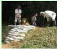
漏水箇所の補修
