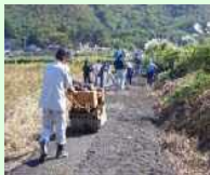
未舗装農道の舗装
