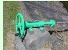
ゲート、バルブの更新
