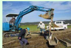
コンクリート水路の更新
