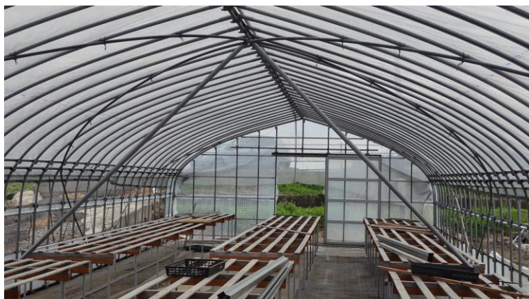
写真 1 1 斜め支柱設置の例
