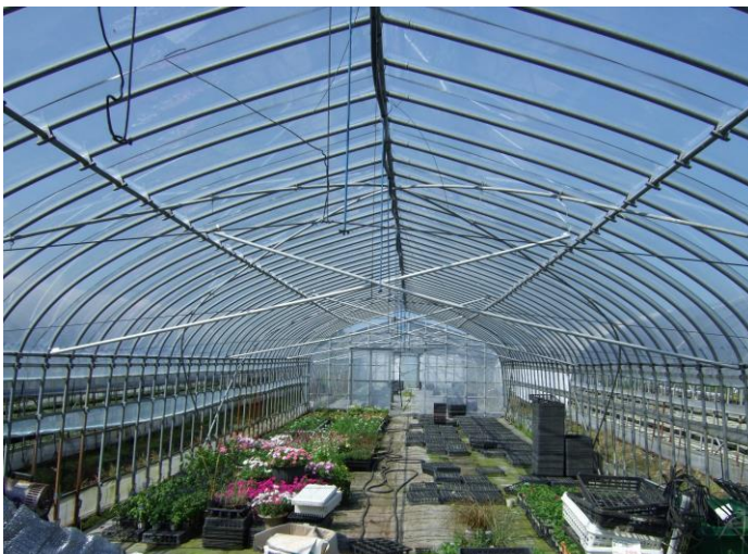
写真6 クロス設置の例
