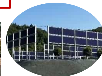
垂直型太陽光発電設備を設置
