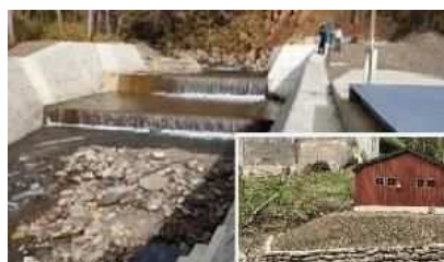
小水力取水口と発電所建屋(他事例)
