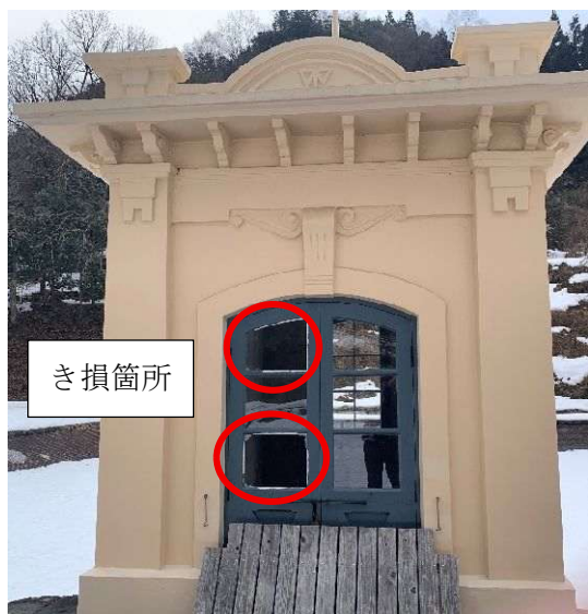
1号濾過池制水井正面
